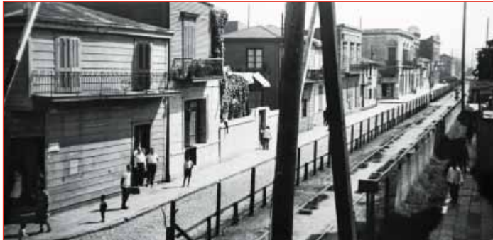
1. "Calle Garibaldi e Magallanes". Typical boquenses houses. Fonte: AGN, Departamento documentos fotográficos, Argentina. Caja 42, sobre 22, negativo B45901, inventario 9842
