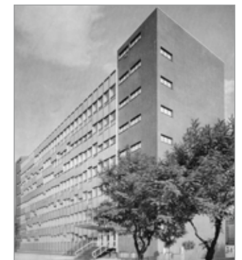
3. L. Mattioni, Technical office building Ercole Marelli in Sesto San Giovanni (Milan), 1959-1962 (Luigi Mattioni Archive)
