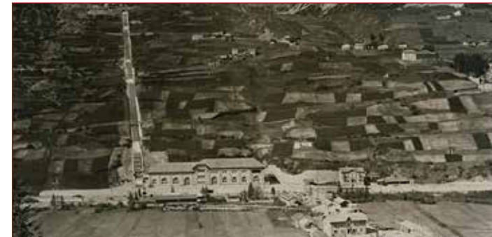
1. Centrale di Fraele and penstocks, Paoletti 1931 (Archivio Fotografico Fondazione AEM)
